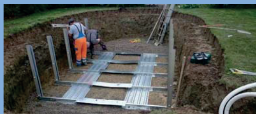
Spezielles Ovalbecken: Seitliche Stützen zusammenbauen
