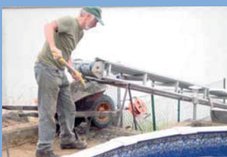
Hinterfüllen mit Mager- oder Sickerbeton (nur bei versenkten Becken)
