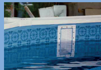
Skimmer und Düsen montieren
