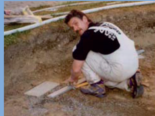
Platten ins Blei setzen
