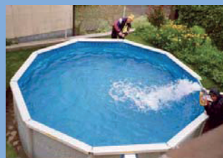
Sitzrand und Stützen montieren
