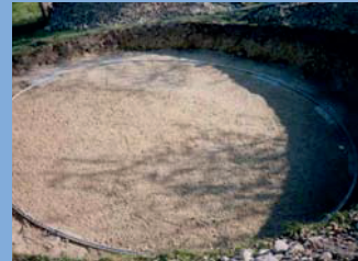
Bodenschiene verlegen
