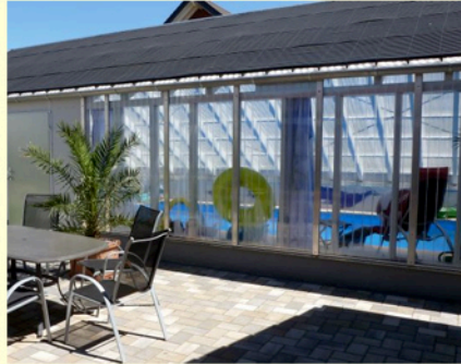
auf der Schwimmhalle
