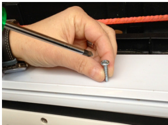
Montieren Klemmschiene
