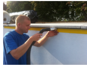
Klemmschiene reinigen
